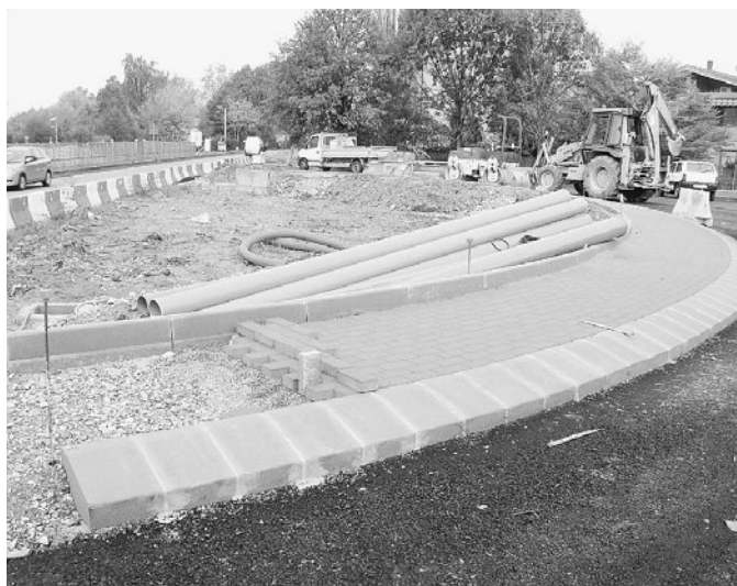
Il cantiere per la realizzazione della rotatoria tra Vignolese e Gherbella
