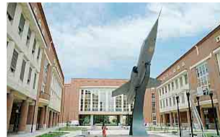
Il campus di Ingegneria
